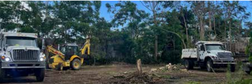
Espacio durante la limpieza del solar. Foto: Comité El Roble Río Piedras
